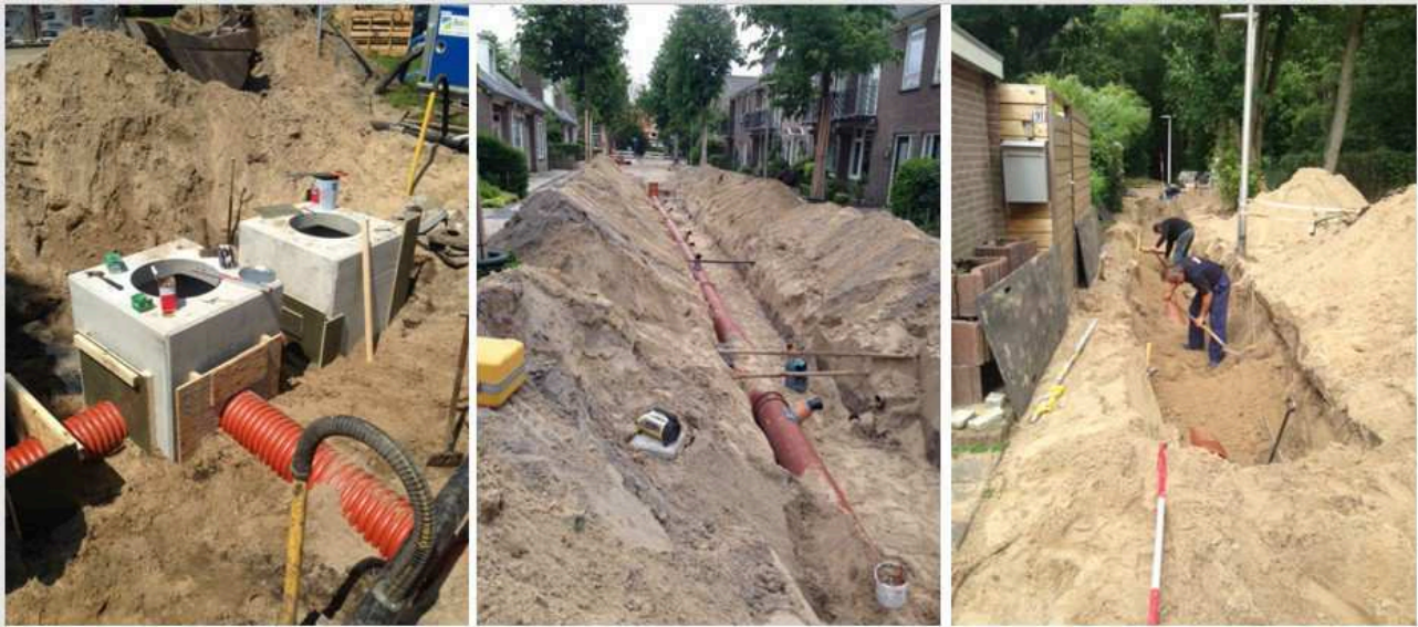
Rioleringswerkzaamheden in Heemstede (Bron: gemeente Heemstede)
